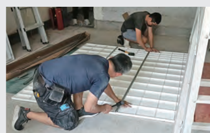
STEP 3 拼接壁板
