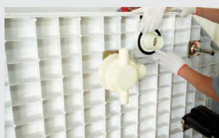
STEP 1 地漏安裝
