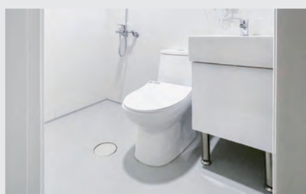
STEP 8 設備安裝
